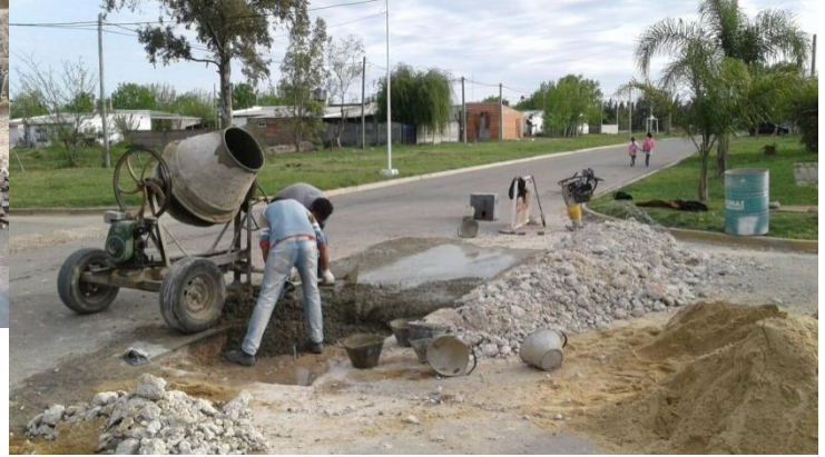
Reparación de Badenes
